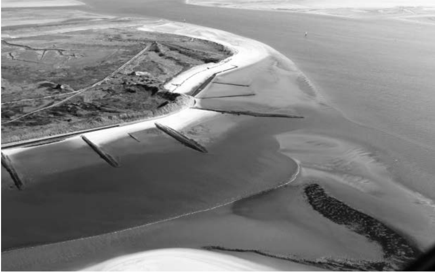
Ankerlagune Spiekeroog-West, anzusteuern von Nordwest direkt auf den Kopf der langen Buhne.
